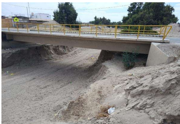
FIGURA N°02: En esta zona se observa una fuerte erosión que ha alcanzado a terrenos de cultivo, dejándolo en riesgo la producción agrícola en ambos márgenes del cauce de la quebrada Hospicio, afectando también la estructura del puente CEFAT, lo que evidencia una degradación continua del cauce de la quebrada.
